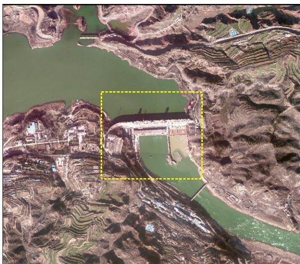
(i) 水库拦河枢纽遥感影像
