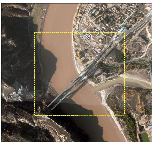
(a) 桥梁1遥感影像
